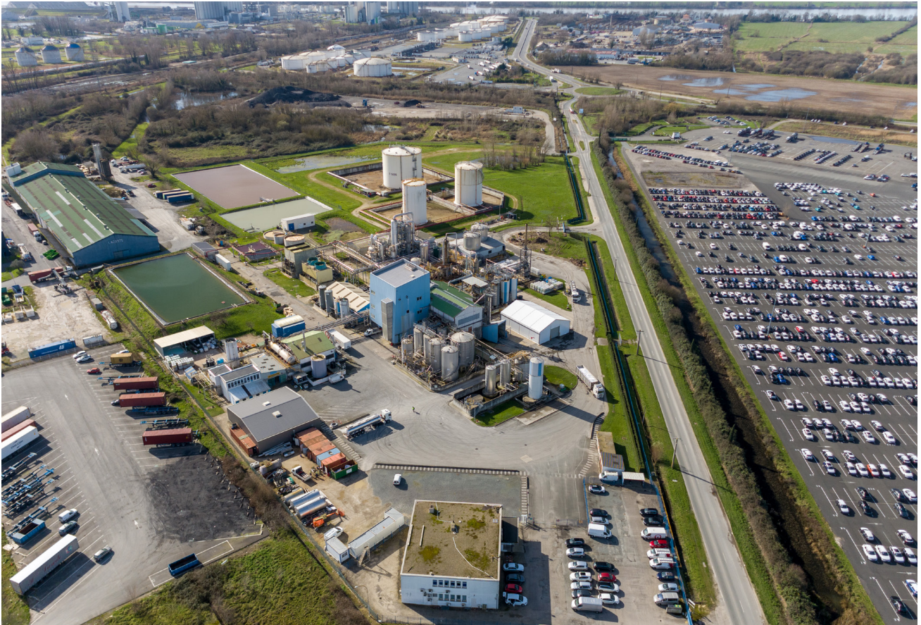
Figure : photographie aérienne du site FORESA-Vue Est-Ouest. Photographies aériennes mars 2021
